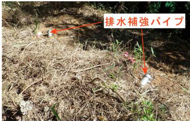
写真1 施工された斜面对策工（崩壊確率 PF=0%仕様）
