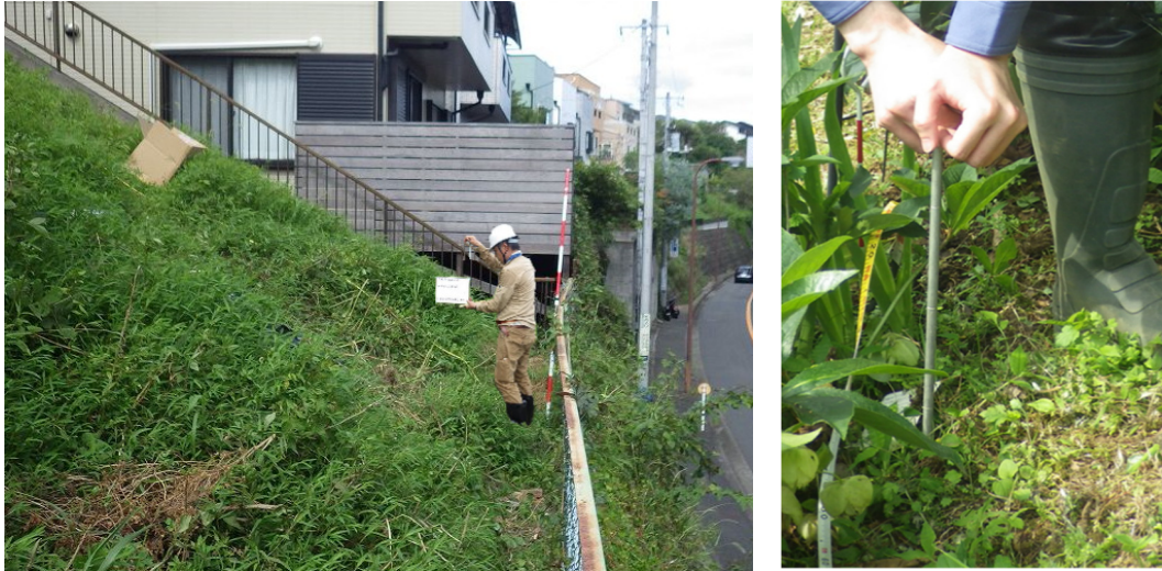
写真-1 限界貫入深度断試験の状況
