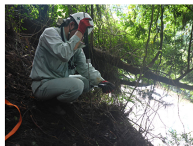
写真-2 ベーンコーンせん断試験状況
