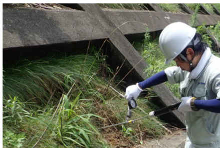
写真-2 ベーンコーンせん断試験実施
