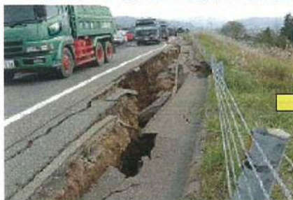
路肩のすべり: 無補修で緊急車両走行
