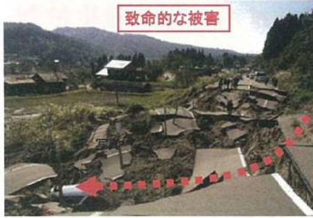
2車線に及んだすべり崩壊事例
