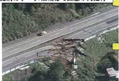
4車線のうち、2車線崩壊
