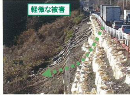
法肩付近に止まったすべり破壊事例
