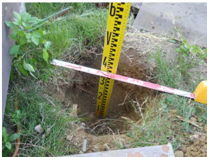
直径30cm、深さ30cmの穴を掘る
