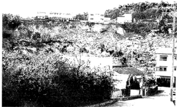
阪神・淡路大震災時、滑動崩落により仁川が埋塞された
